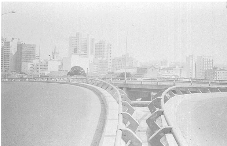
imagem 4- José Gomes Guarnieri. [Viaduto Miguel Vicente Cury, Campinas, SP, 1963]. Fundo JGG– CMU
