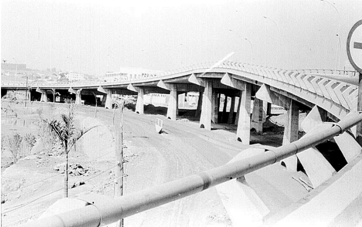
Imagem 3 - José Gomes Guarnieri. [Viaduto Miguel Vicente Cury, Campinas, SP, 1963?]. Fundo JGG – CMU
