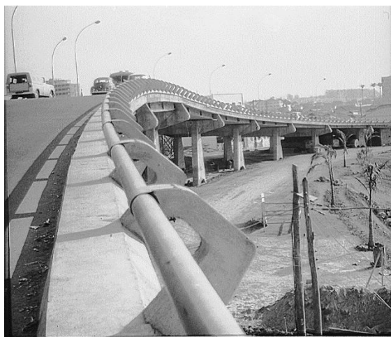
imagem 2 - José Gomes Guarnieri. [Viaduto Miguel Vicente Cury, Campinas, SP, 1963?]. Fundo JGG – CMU
