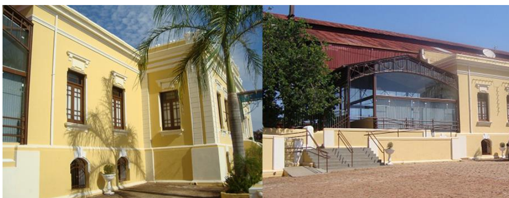
Figura 1: Prolongamento do corpo central e porão alto com gaterias para ventilação; Cobertura Lateral. Fotos: Ana Lúcia Arantes da Silva, 2012.
